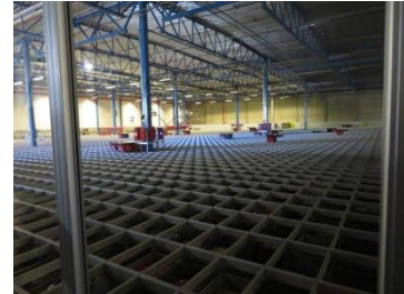
(写真: 自動倉庫の上部をメザニンから見たところ)
